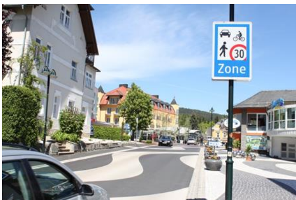
© Amt der Kärntner Landesregierung, Abteilung 9 Straßen und Brücken, Straßenbauamt Klagenfurt
