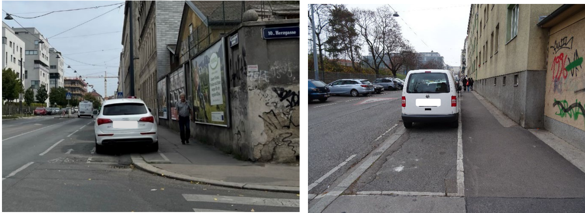
Abbildung 29 Parken auf Gehsteig, z.B. Landgutgasse, Laimäckergasse
