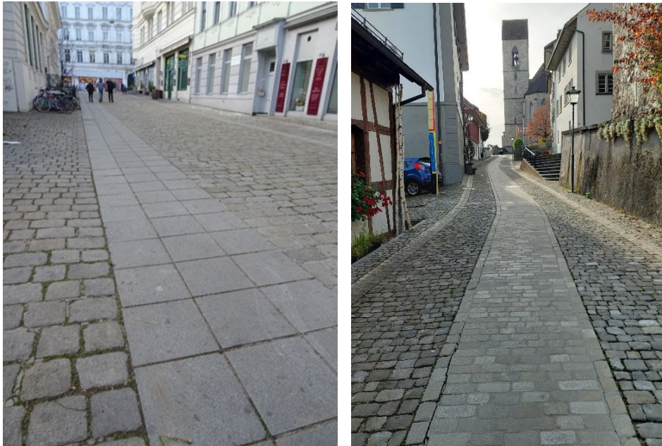
Abbildung 27 barrierefreier Streifen in Pflasterung, z.B. Fußgängerzone Alserbachstraße (Wien), Rapperswill (Schweiz)
