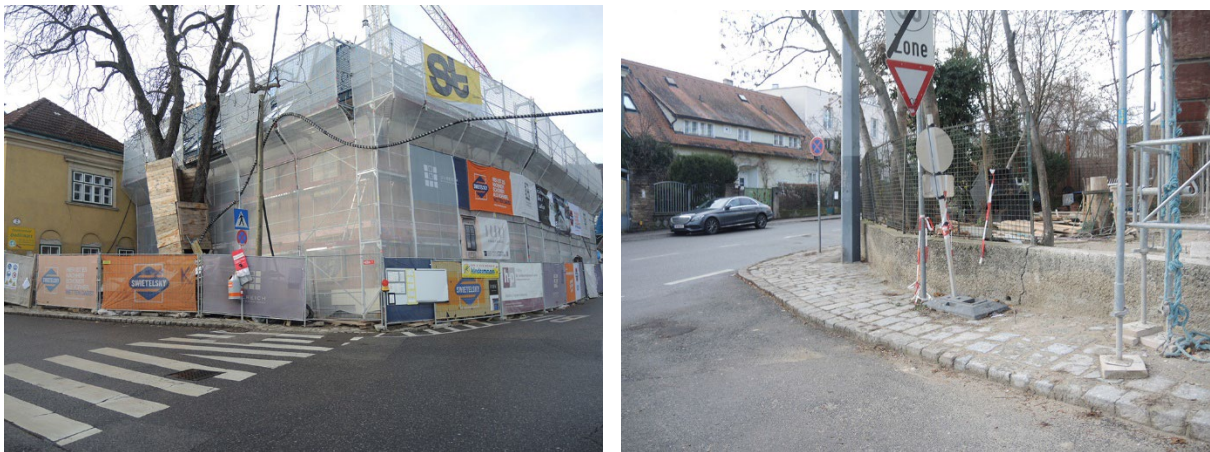
Abbildung 30 Fußwege wegen Baustellen eingeschränkt
