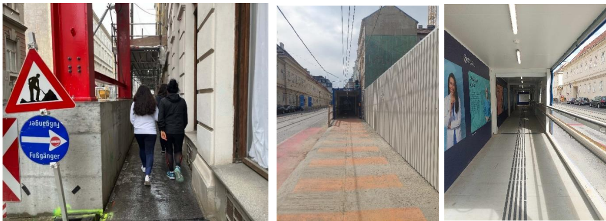
Abbildung 27 Baustellensicherheit, Bsp. Mariannengasse, Spitalgasse
