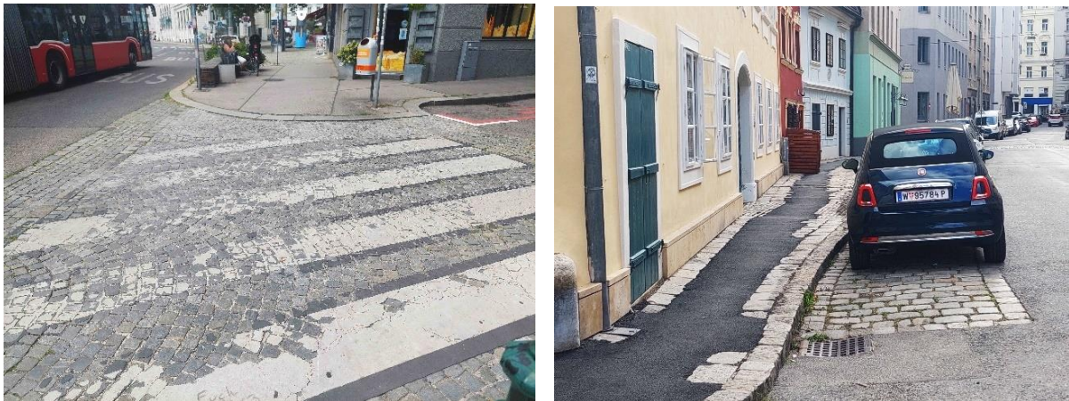
Abbildung 19 Instandhaltung Bodenmarkierung, z.B. Pfluggasse, Pflaster am Gehsteig, z.B. Reznicekgasse
