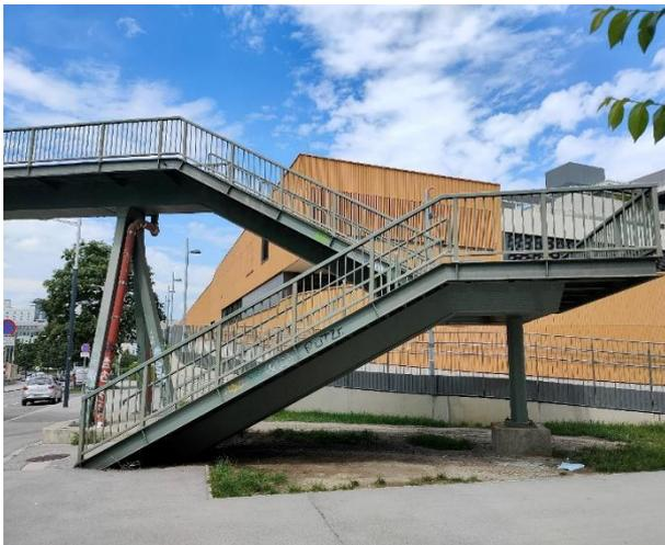
Abbildung 21: Bestandssteg über die S-Bahn-Stammstrecke, nicht barrierefrei (tbw research, 2024)
