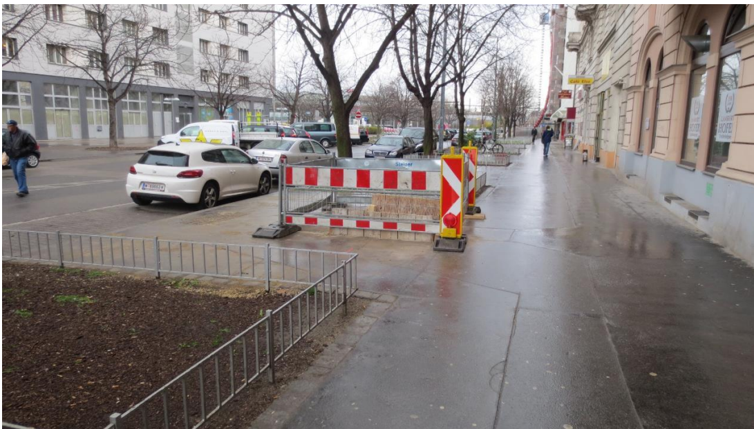
Abbildung 17: Baustellenabsicherung mit kontrastierenden Elementen
