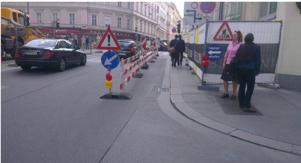
Abbildung 19: Gehsteigführung bei Baustelle
