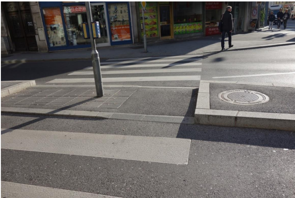
Abbildung 6: Variante einer Mittelinsel mit Absenkung auf Fahrbahnniveau aus Graz
