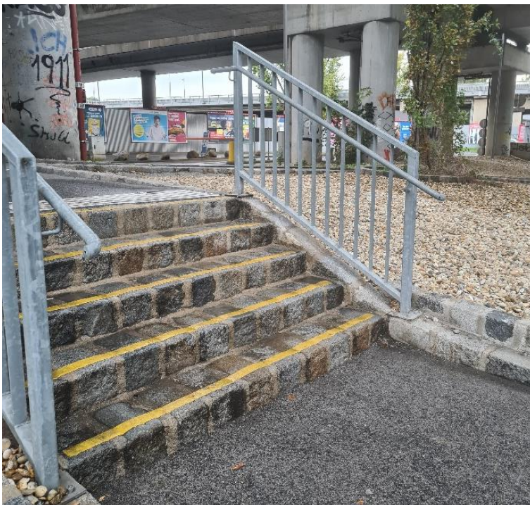
Abbildung 7: Treppe mit optisch kontrastierenden und taktil erfassbaren Markierungen
