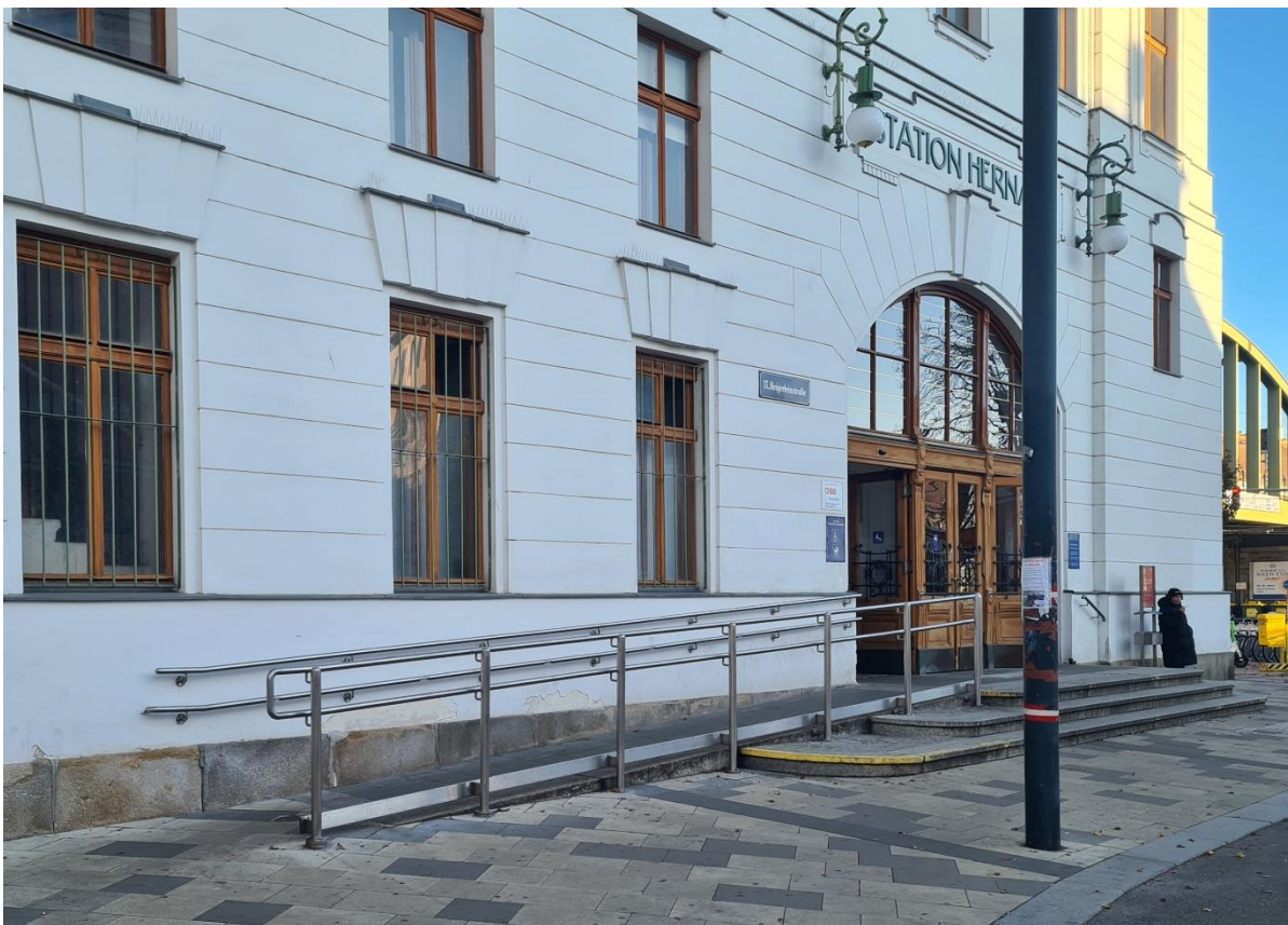
Abbildung 8: Rampe mit beidseitigem Handlauf, Radabweiser und kontrastierender Markierung
