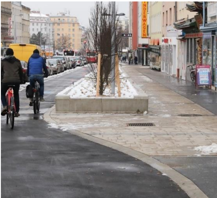
Abbildung 9: Abgrenzung des Radweges zum Gehsteig mittels Radwegbegrenzungsstein
