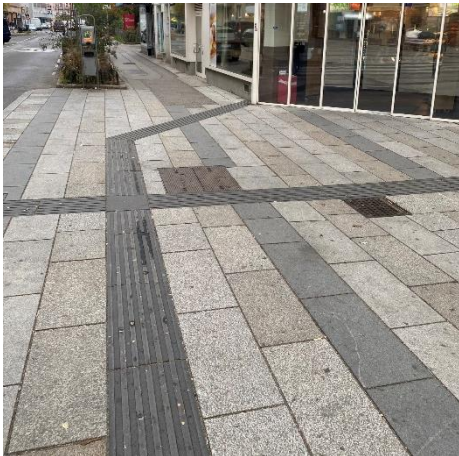
Abbildung 12: Links: Taktile Bodeninformationssysteme aus Stein; rechts: Taktile Bodeninformationssysteme in Bodenmarkierungsfarbe
